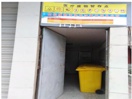
医疗废物暂存间
