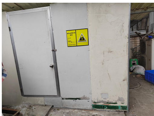
危废暂存间外部
