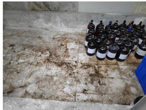
危废暂存间内部
