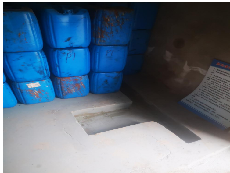
暂存间应急池
