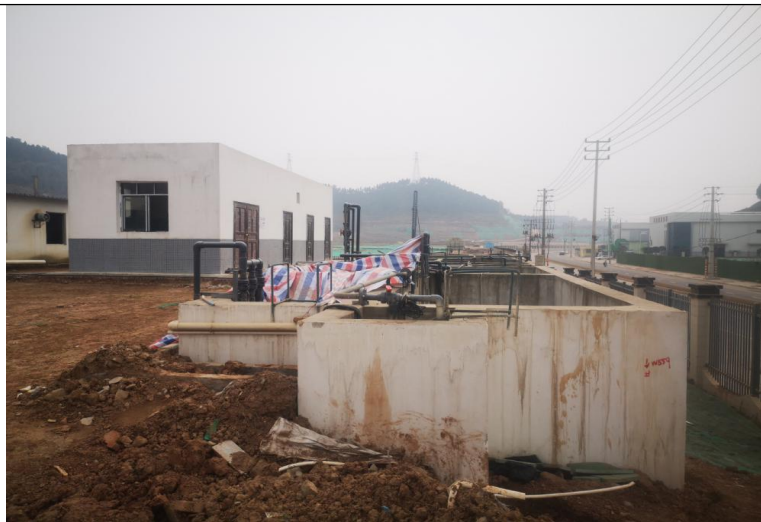
厂区废水二级生化处理站
