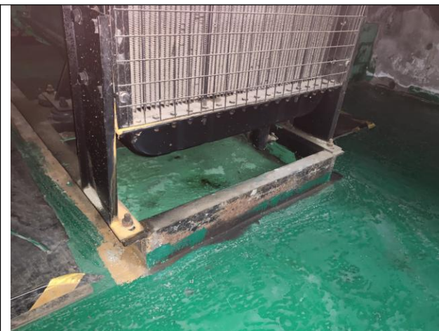
发电机减振基座
