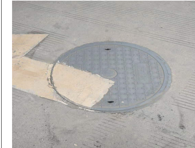
地下水监测井
