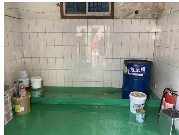
危废暂存间内部
