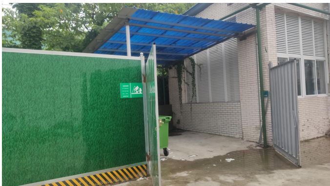
一般固废暂存间
