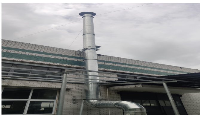
油墨有机废气排气筒
