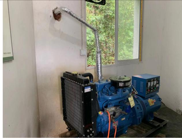
带减振基座发电机
