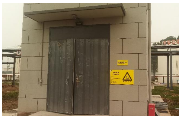
危废暂存间一
