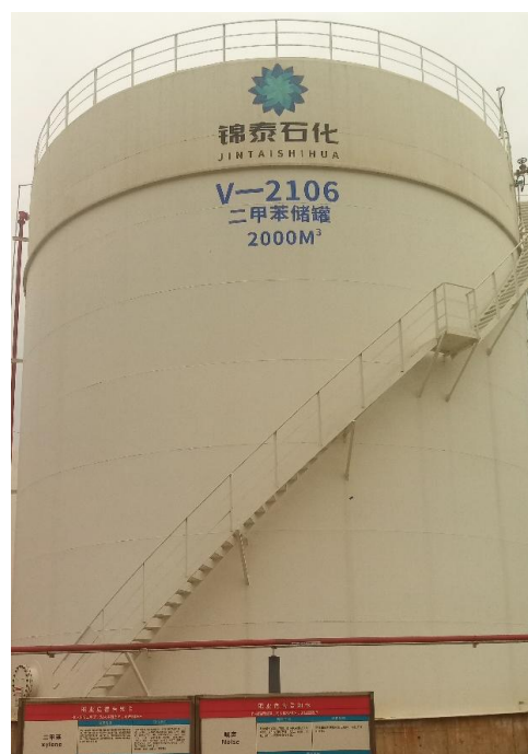
V-2106 二甲苯储罐
