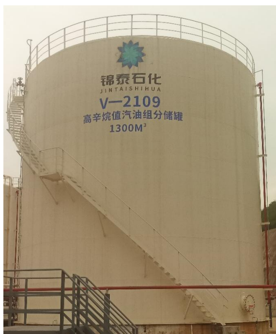
V-2109 高辛烷值汽油组分储罐
