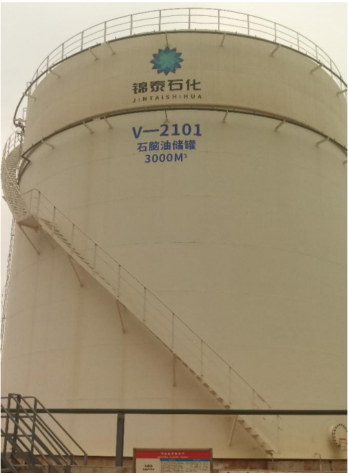
V-2101 石脑油储罐
