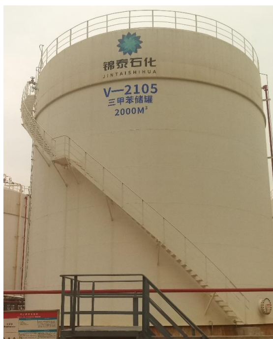
V-2105 三甲苯储罐
