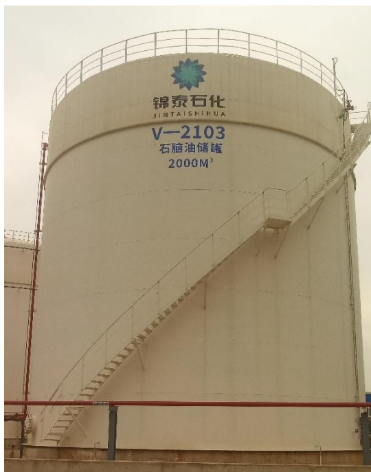
V-2103 石脑油储罐
