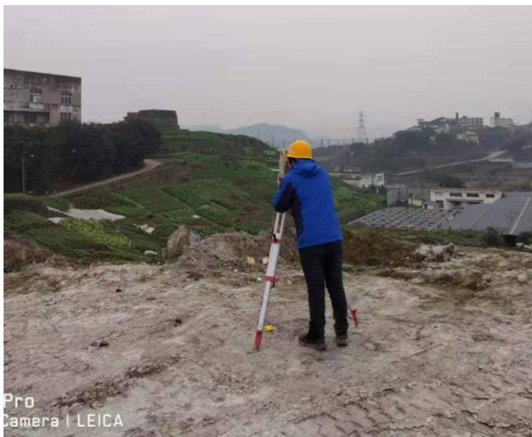
图 6.1-1 放样定点实景图
