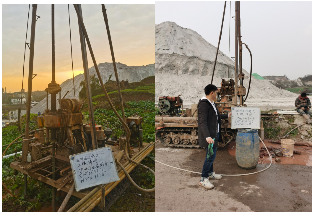
图 6.1-7 现场钻井实景
